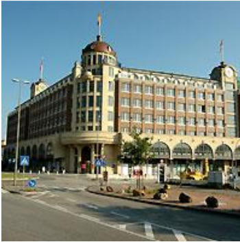
Intellivate Zentrale im Störtebeckerhaus in Hamburg
